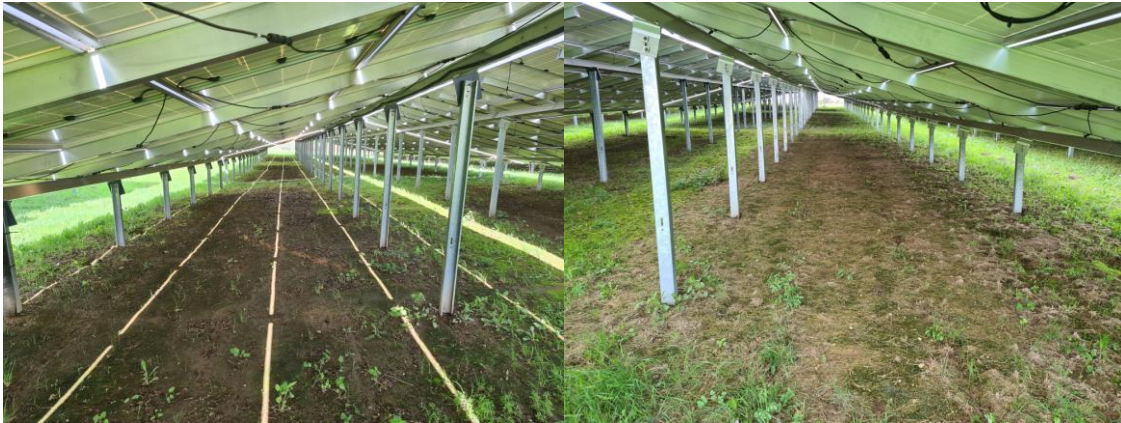
Abb. 13: Verschattungseffekt einer herkömmlichen Ost-West Anlage und daraus resultierend keine geschlossene Vegetationsdecke
