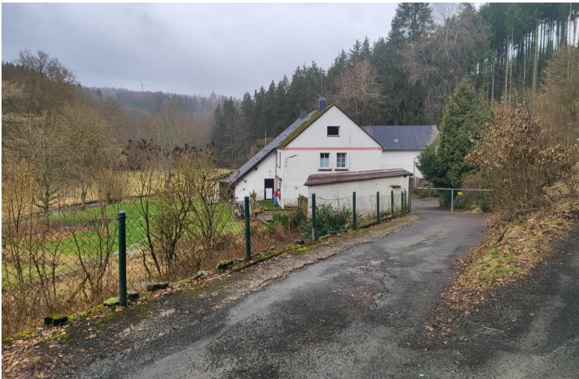
Abbildung 22: Blick auf die Zufahrt und das Gebäude der Nickelsmühle.
