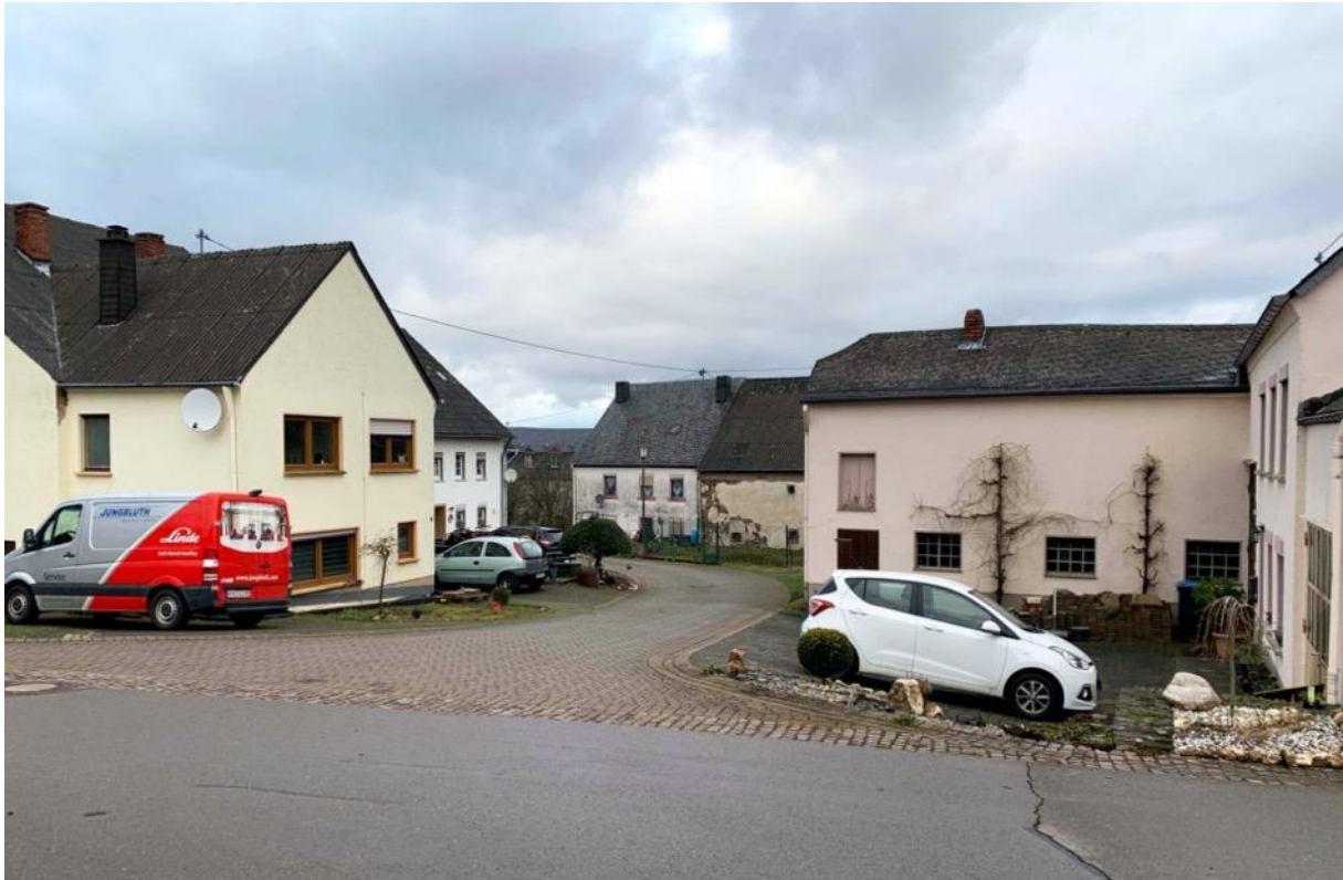
Abbildung 23: Alte Bausubstanz in der Borwiese. Quelle: Eigene Aufnahme.
