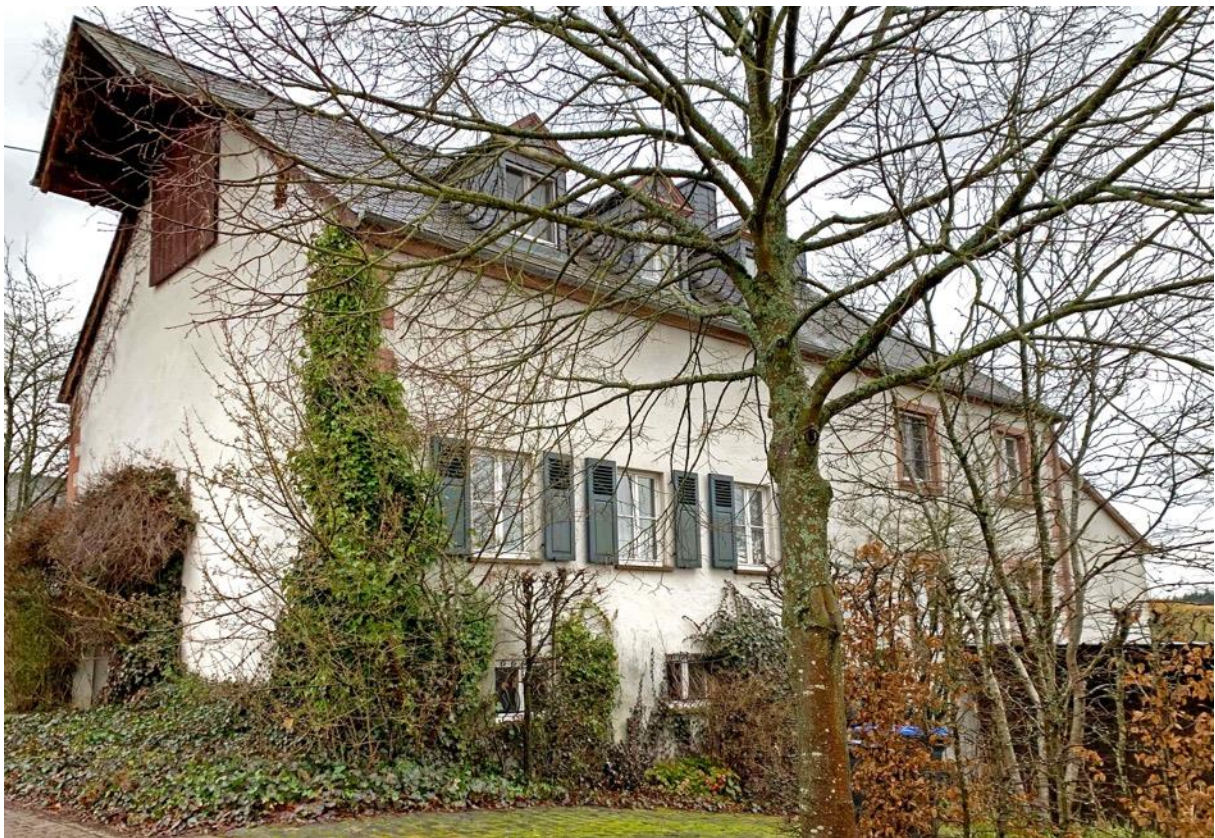
Abbildung 13: Im Stallbereich ungenutztes Gebäude mit überdachter Einbringöffnung, Klappläden und Giebelgauben. Quelle: Eigene Aufnahme.
