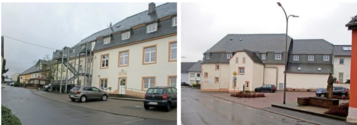
Abbildung 24: Das Bürgerhaus mit Frischemarkt und Parkplätzen von der Hofstraße aus (li.) und mit dem Freibereich von der Hauptstraße (re.). Quelle: Eigene Aufnahme.
