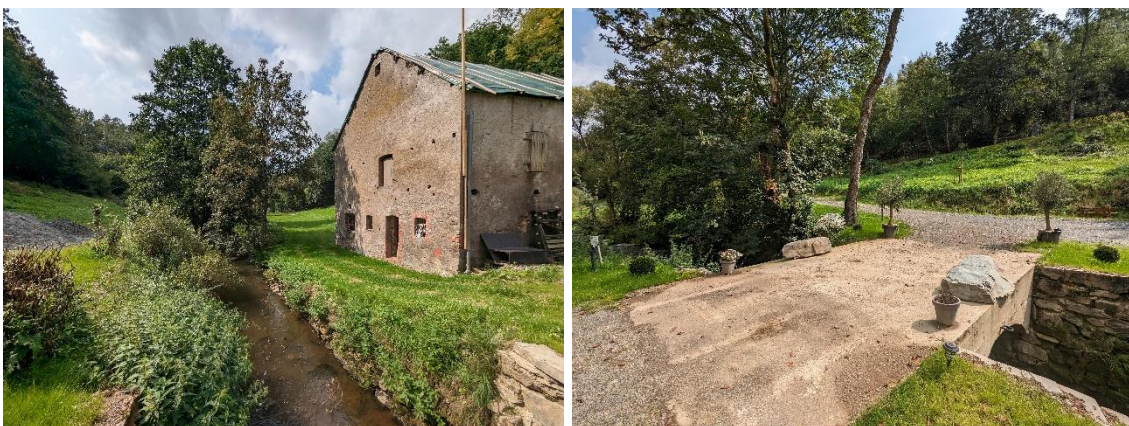
Abbildung 10: Links – Blick auf den Bach mit Uferbefestigung. Rechts – Blick auf Brücke.
