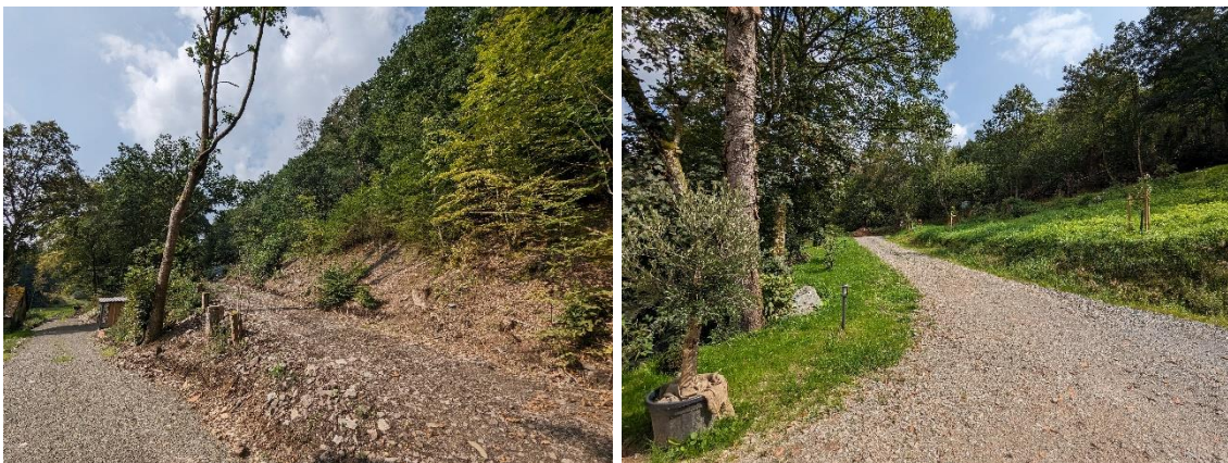
Abbildung 4: Links – Blick auf die Zufahrten zum Gelände im nördlichen Planungsraum. Rechts – Blick auf die Zufahrt zum Gelände im östlichen Planungsraum.
