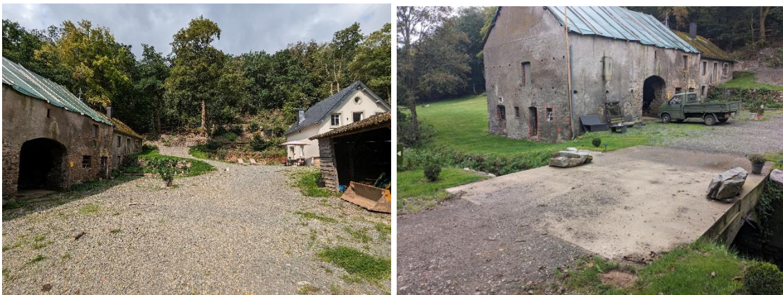
Abbildung 2: Links - Blick auf den Geltungsbereich mit Waldflächen im Hintergrund. Rechts – Blick auf die Brücke, welche Zugänglichkeit zum Grundstück gewährleistet.
